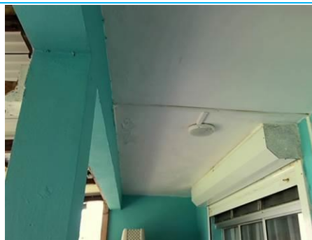
Matériaux : M008 Prélèvement : P008 Description : enduit + peinture Localisation : BAT 3 - Façade nord - Plafond balcon Résultat : Présence d'amiante
