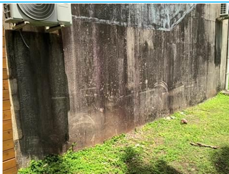
Matériaux : M001 Prélèvement : P001 Description : enduit + peinture Localisation : BAT 3 - Façade ouest - Mur blanc Résultat : Présence d'amiante
