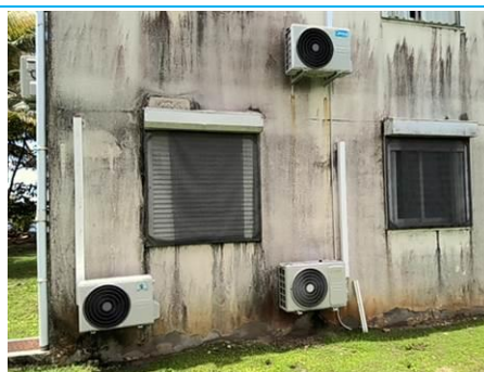
Matériaux : M010 Prélèvement : P010 Description : enduit + peinture Localisation : BAT 3 - Façade sud - Mur Résultat : Présence d'amiante
