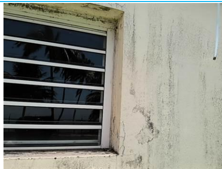
Matériaux : M006 Prélèvement : P006 Description : enduit + peinture Localisation : BAT 3 - Façade nord - Embrasure fenêtre Résultat : Présence d'amiante
