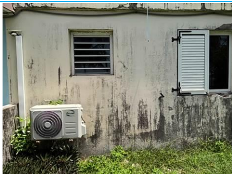
Matériaux : M005 Prélèvement : P005 Description : enduit + peinture Localisation : BAT 3 - Façade nord - Mur blanc Résultat : Présence d'amiante
