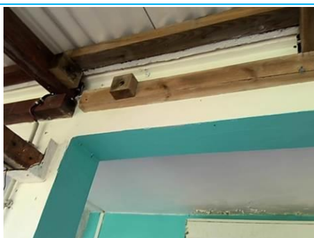
Matériaux : M009 Prélèvement : P009 Description : enduit + peinture Localisation : BAT 3 - Façade nord - Poutre balcon Résultat : Présence d'amiante
