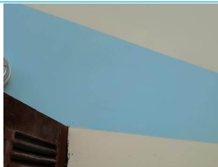
Matériaux : M002 Prélèvement : P002 Description : enduit + peinture Localisation : BAT 3 - Façade est - Mur bleu Résultat : Présence d'amiante
