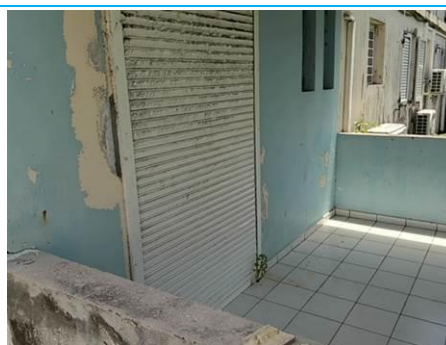
Matériaux : M004 Prélèvement : P004 Description : enduit + peinture Localisation : BAT 3 - Façade nord - Mur bleu Résultat : Absence d'amiante
