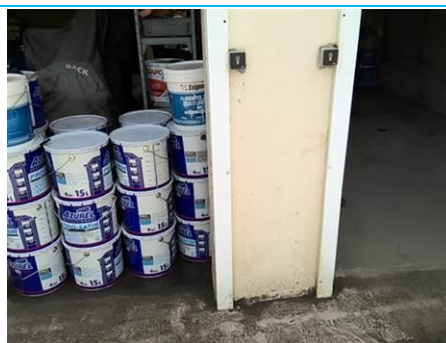
Matériaux : M012 Prélèvement : P012 Description : enduit + peinture Localisation : BAT 3 - Façade sud - Poteau Résultat : Présence d'amiante
