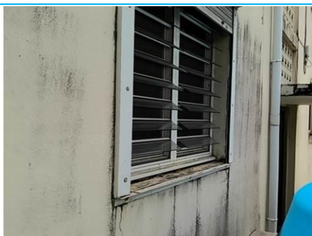
Matériaux : M011 Prélèvement : P011 Description : enduit + peinture Localisation : BAT 3 - Façade sud - Embrasure fenêtre Résultat : Présence d'amiante
