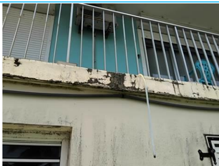
Matériaux : M007 Prélèvement : P007 Description : enduit + peinture Localisation : BAT 3 - Façade nord - Tranche horizontale Résultat : Absence d'amiante
